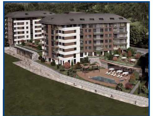
Terrace Koru Projesi
