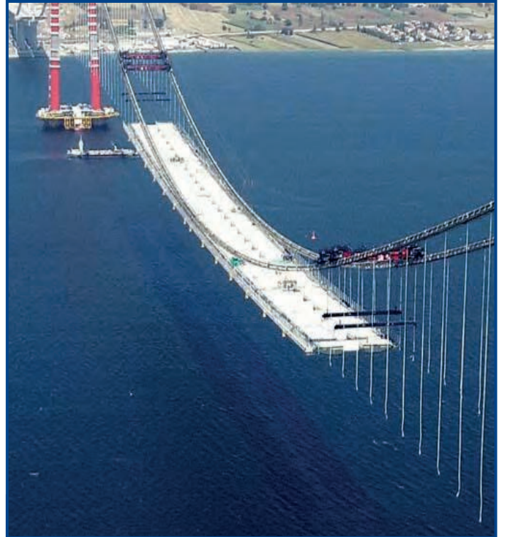
Çanakkale Köprüsü / Saha Mobilizasyon Panoları
