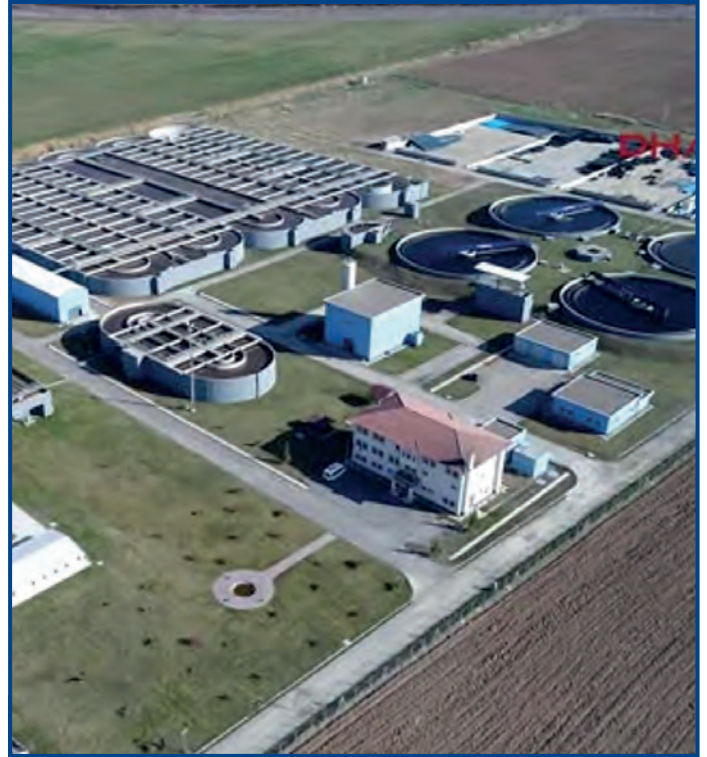
Sivas Atık Su Arıtma Tesisi
