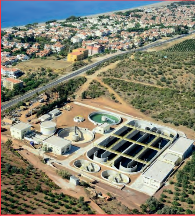
İzmir Mordoğan Arıtma Tesisi
